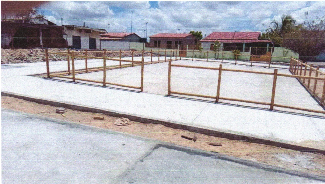
Foto 05- FORNECIMENTO E MONTAGEM DE CERCA DE PROTEÇÃO EM EUCALIPTO CLOEZIANA TRATADO A BASE DE CCA EM AUTOCLAVE, COM APLICAÇÃO DE STAIN NA COR NATURAL COM DUPLO FILTRO SOLAR, DIAMETRO DO EUCALIPTO DE 6 A 8 CM, COM ANTI-RACHA NA EXTREMIDADE. FECHAMENTO COM TELA DE ALAMBRADO FIO Nº 12 REVESTIDO DE PVC, MALHA 2.1/2 X 2.1/2", FIXADO COM FIO Nº 14 REVESTIDO EM PVC, MÓDULO MEDINDO 1,50 X 1,00M, PARAFUSOS GALVANIZADOS COM TRAVAMENTO CLICKFIX, CONFORME PROJETO
