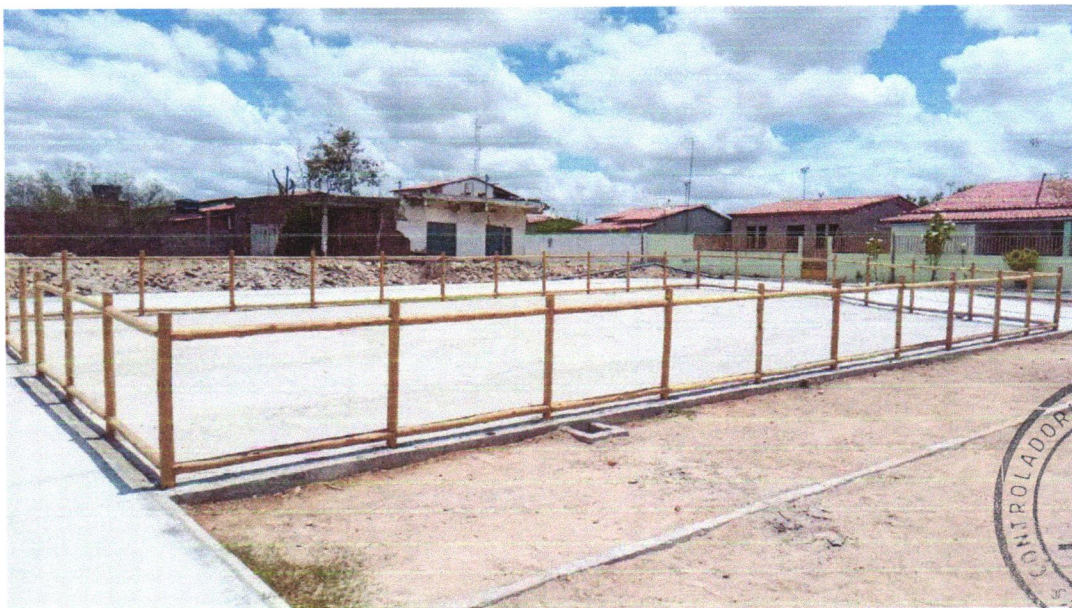
Foto 06 - FORNECIMENTO E MONTAGEM DE CERCA DE PROTEÇÃO EM EUCALIPTO CLOEZIANA TRATADO A BASE DE CCA EM AUTOCLAVE, COM APLICAÇÃO DE STAIN NA COR NATURAL COM DUPLO FILTRO SOLAR, DIAMETRO DO EUCALIPTO DE 6 A 8 CM, COM ANTI-RACHA NA EXTREMIDADE. FECHAMENTO COM TELA DE ALAMBRADO FIO Nº 12 REVESTIDO DE PVC, MALHA 2.1/2 X 2.1/2", FIXADO COM FIO Nº 14 REVESTIDO EM PVC, MÓDULO MEDINDO 1,50 X 1,00M, PARAFUSOS GALVANIZADOS COM TRAVAMENTO
