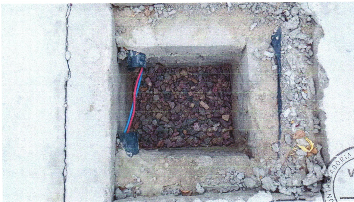
Foto 08 - CABO DE COBRE ISOLADO HEPR (XLPE), RIGIDO, 16MM 2 , 1KV/90°C
