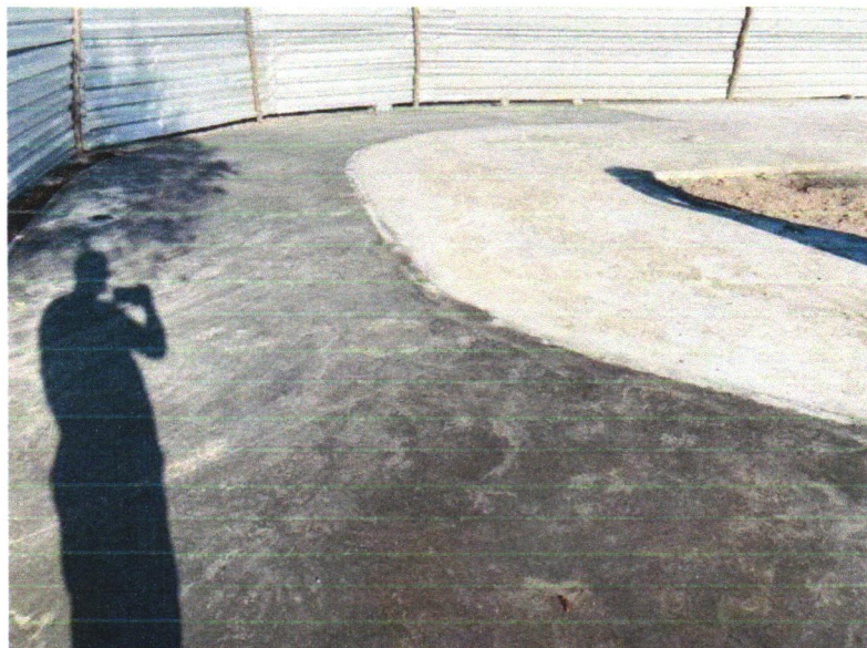
Foto 02 – PAVIMENTAÇÃO EM CONCRETO, COM ESPESSURA DE 7 CM, COM ACABAMENTO FEITO UTILIZANDO ALISADORA DE CONCRETO (HELICOPTERO), INCLUIDO TELA DE AÇO SOLDADA NERVURADA CA60, Q196 (3,11 KG/M2), DIAMETRO DO FIO 5.0 MM, LARGURA = 2,45 M, ESPAÇAMENTO DA MALHA = 10 X 10 CM, JUNTA DE DILATAÇÃO EM PVC A CADA 2,00 M, CONCRETO FCK = 20 MPA
